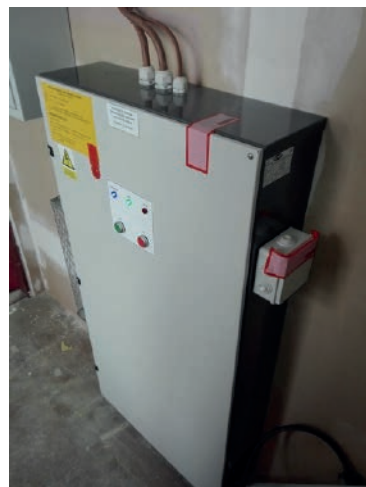
Zdroj: ASTIP LIFTBACK 15kVA/3F - 60 min. pro výtah OTIS. Akce: ubytovna Hodonín, výtah OTIS 6,7kW
