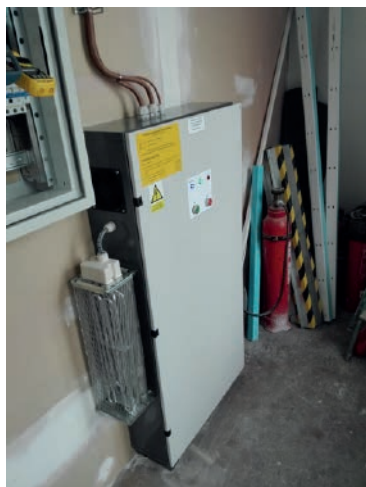
Zdroj: ASTIP LIFTBACK 15kVA/3F - 60 min. pro výtah OTIS. Akce: ubytovna Hodonín, výtah OTIS 6,7kW
